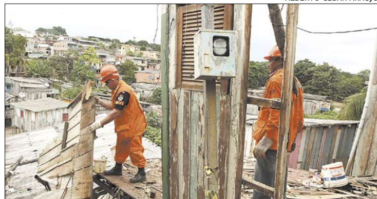
Equipes da Defesa Civil demoliram as três casas de madeira
